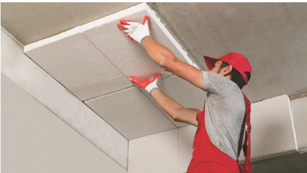
Colocación en techos para mejorar aislamiento térmico y ó fuego.
