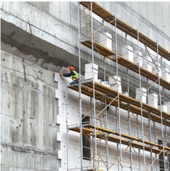
Aislamiento MINEPOR en fachadas de hormigón.
