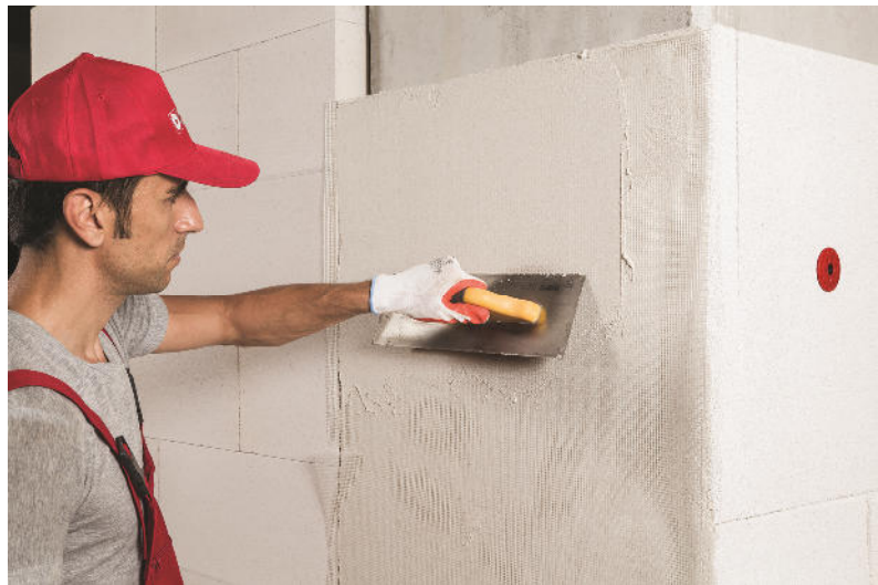
Sujección y terminación de las placas MINEPOR
