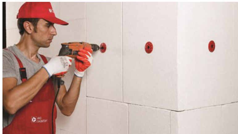
Sujección final sobre pilares.
