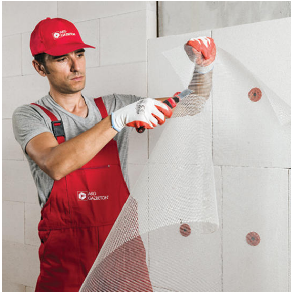
Colocación fibra de vidrio.
